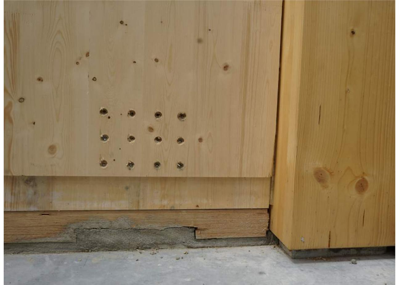
Auf der Bodenplatte verankertes Schlitzblech + selbstbohrende Stabdübel + nachträglicher Holzverschluss
