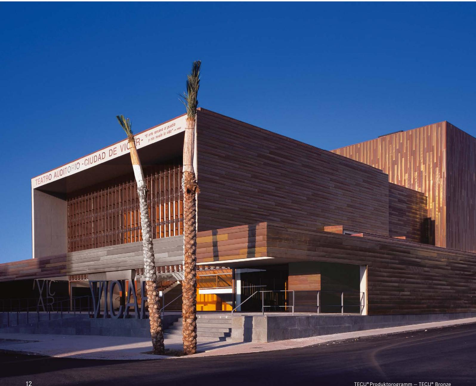
Die warme rot-braune Oberfläche von TECU® Bronze zeigt unter freier Bewitterung eine sehr typische farbliche Entwicklung. Nach einer braun-roten Oxidationsphase mit einer braungrauen Färbung im Materialgrund erfolgt ganz allmählich eine Durchfärbung des Materials zu dunkelbraun-anthrazit. Die anschließende Patinabildung, an geneigten Flächen, erfolgt erheblich langsamer als bei klassischem Kupfer – und mit ganz individuellen Ergebnissen.
